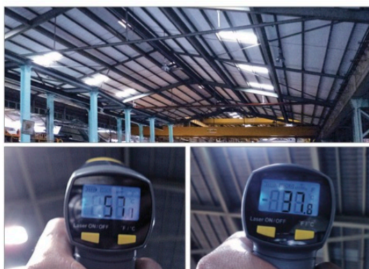
גג האולם מבפנים (לפני ואחרי): הטמפרטורה הופחתה ב-19.3 מעלות צ'. התועלת: שיפור בתנאי עבודה, חסכון באנרגיה, הפחתת העלות של טיפול בגג.
